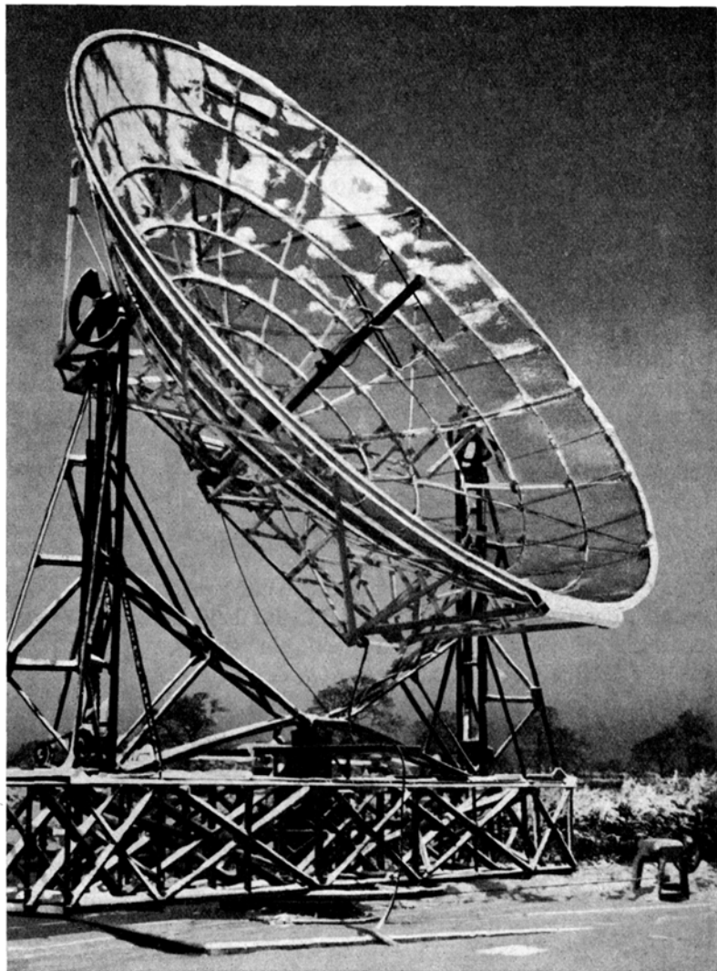
Abb. 2a. – Empfangsspiegel des Radioteleskops für \lambda = 1,89 m an der Jodrell-Bank-Station in Cheshire (England). Der drahtförmige Parabolspiegel hat einen Durchmesser von 66,5 m und eine Brennweite von 38,4 m und wird unter anderem zum Empfang der Strahlung des Andromedanebels und anderer aussergalaktischer Spiralnebel verwendet.
